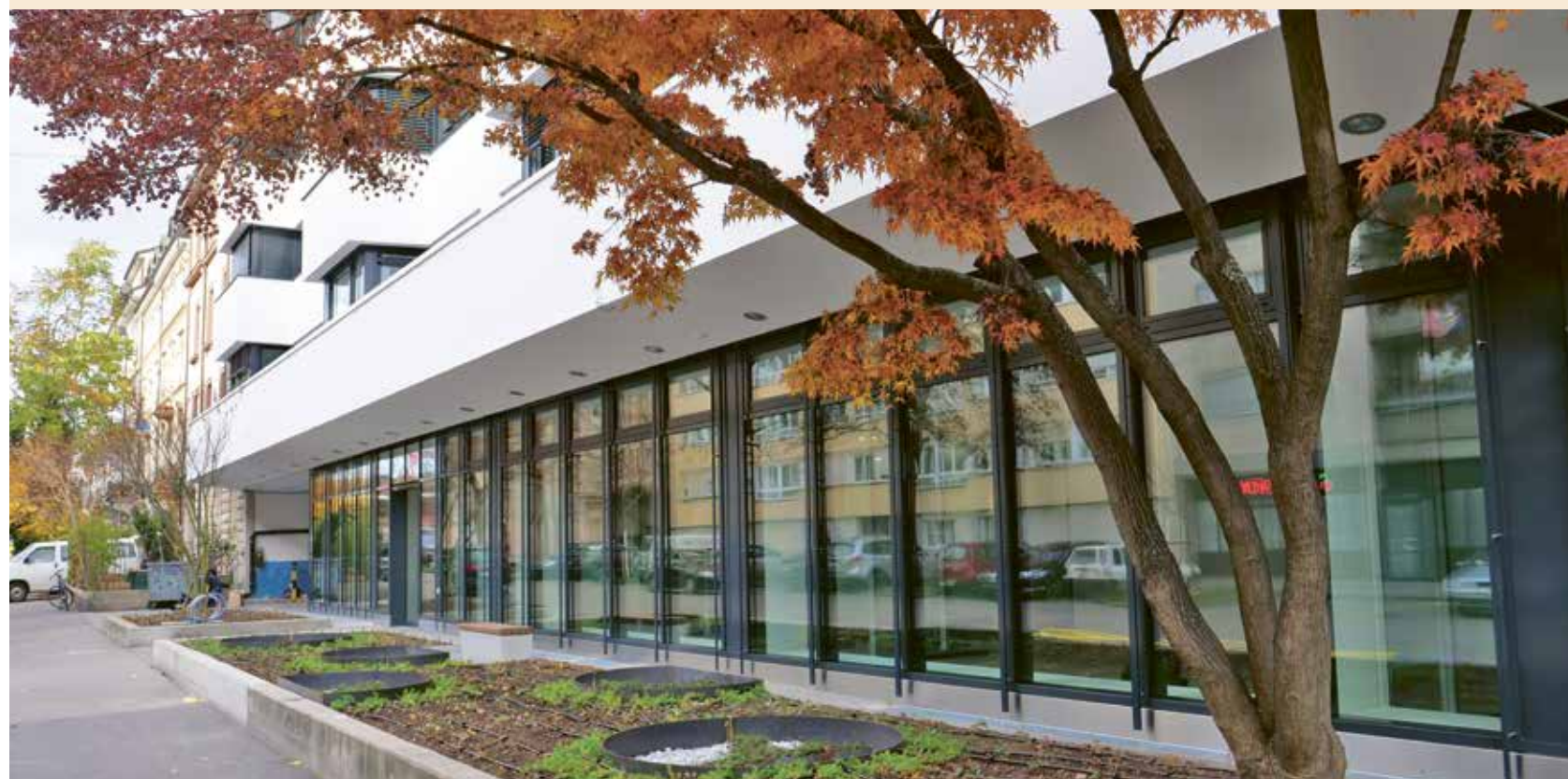
Die Aussenansicht des neuen Standorts an der Vogesenstrasse 134
